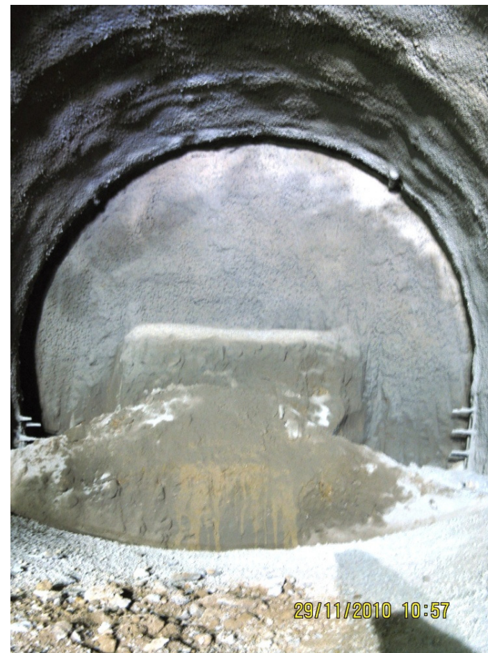
Proteção de frente de escavação com concreto projetado.
