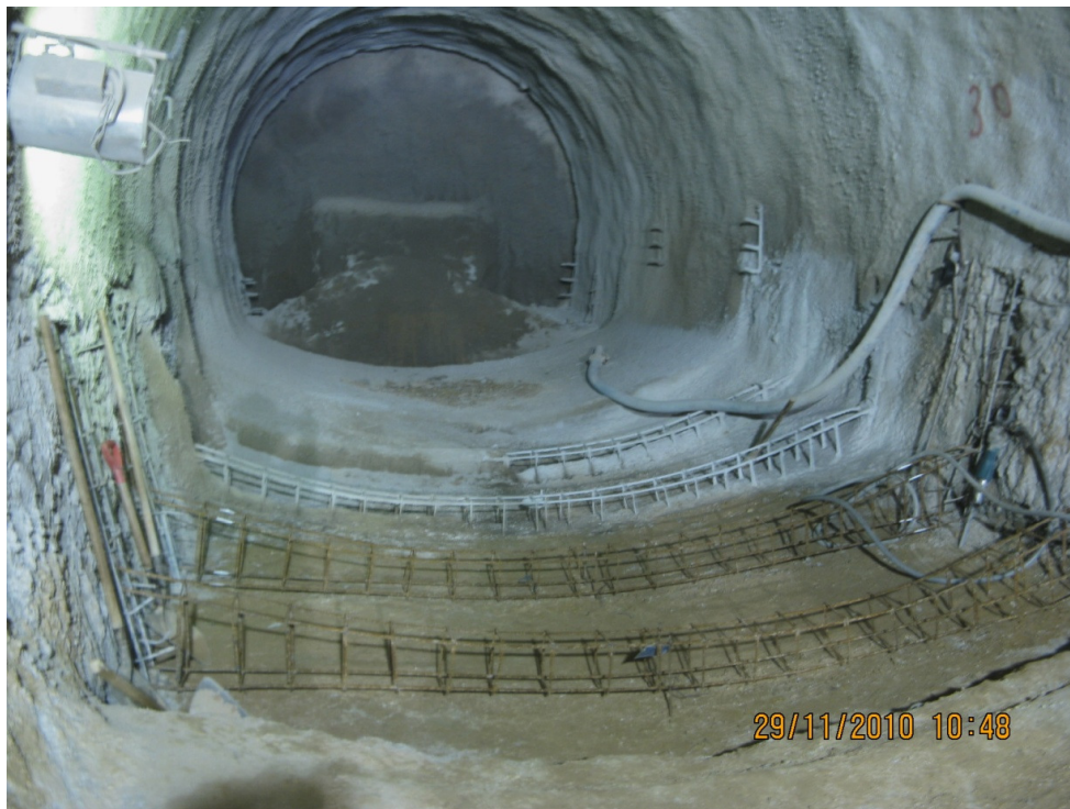
Execução de segmento de invert de 3m.
